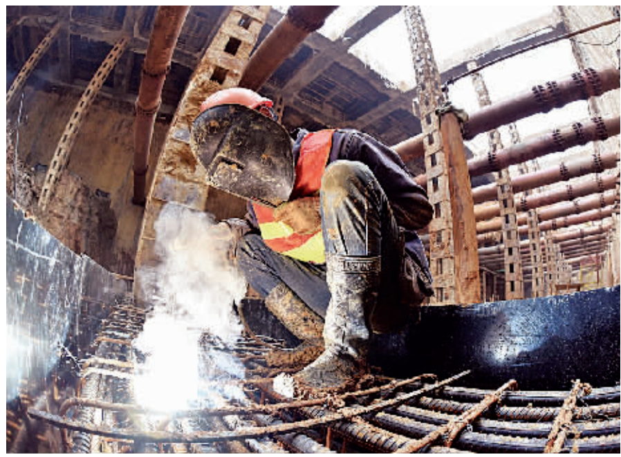
在基坑里建设者们正在对钢筋进行焊接。记者詹松 摄
